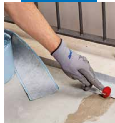
Aplicarea de Mapeband SA la îmbinarea cu diferite margini ale altor materiale
