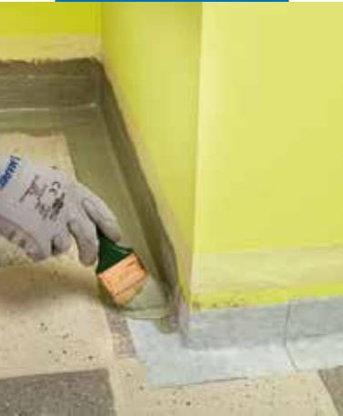
Aplicarea de Mapeband SA pe o sapa de ciment
